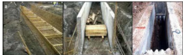
شکل شماره ۱۸- آرماتوربندی (a)، بر کردن مصالح پشت دیوار (b) و عملیات پیش حفاری دیوار راهنما (c)
