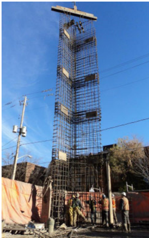
شکل شماره ۲۳- نحوه استقرار شبکه آرماتور
