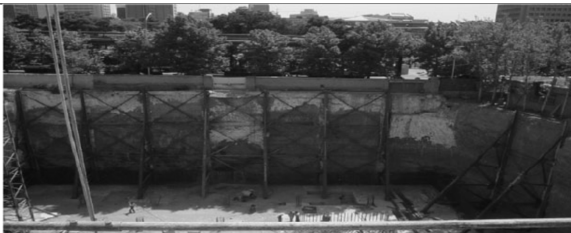
تصویر شماره ۹: اجرای تحکیمات به روش سازه نگهدارنده خرابائی
