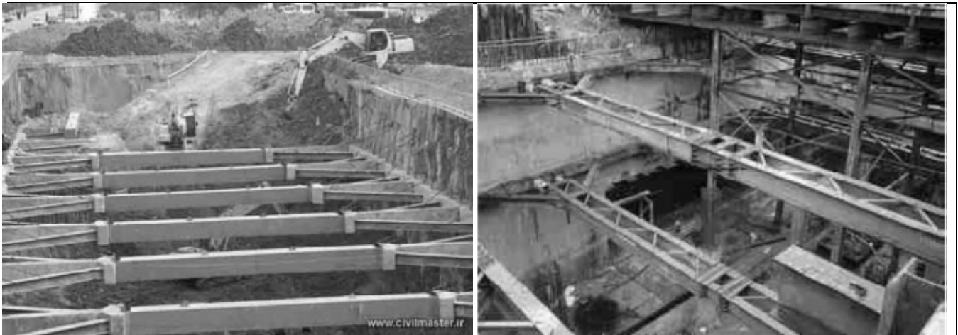
تصویر شماره ۶: اجرای تحکیمات به روش مهار متقابل
