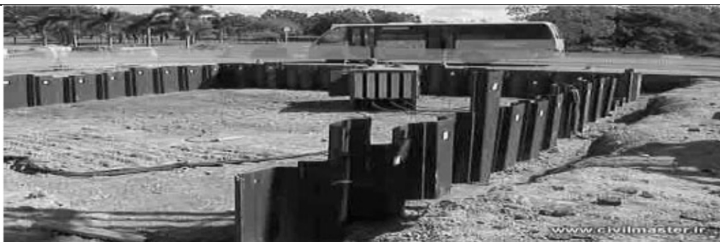
تصویر شماره ۸: اجرای تحکیمات به روش سپرکوبی
