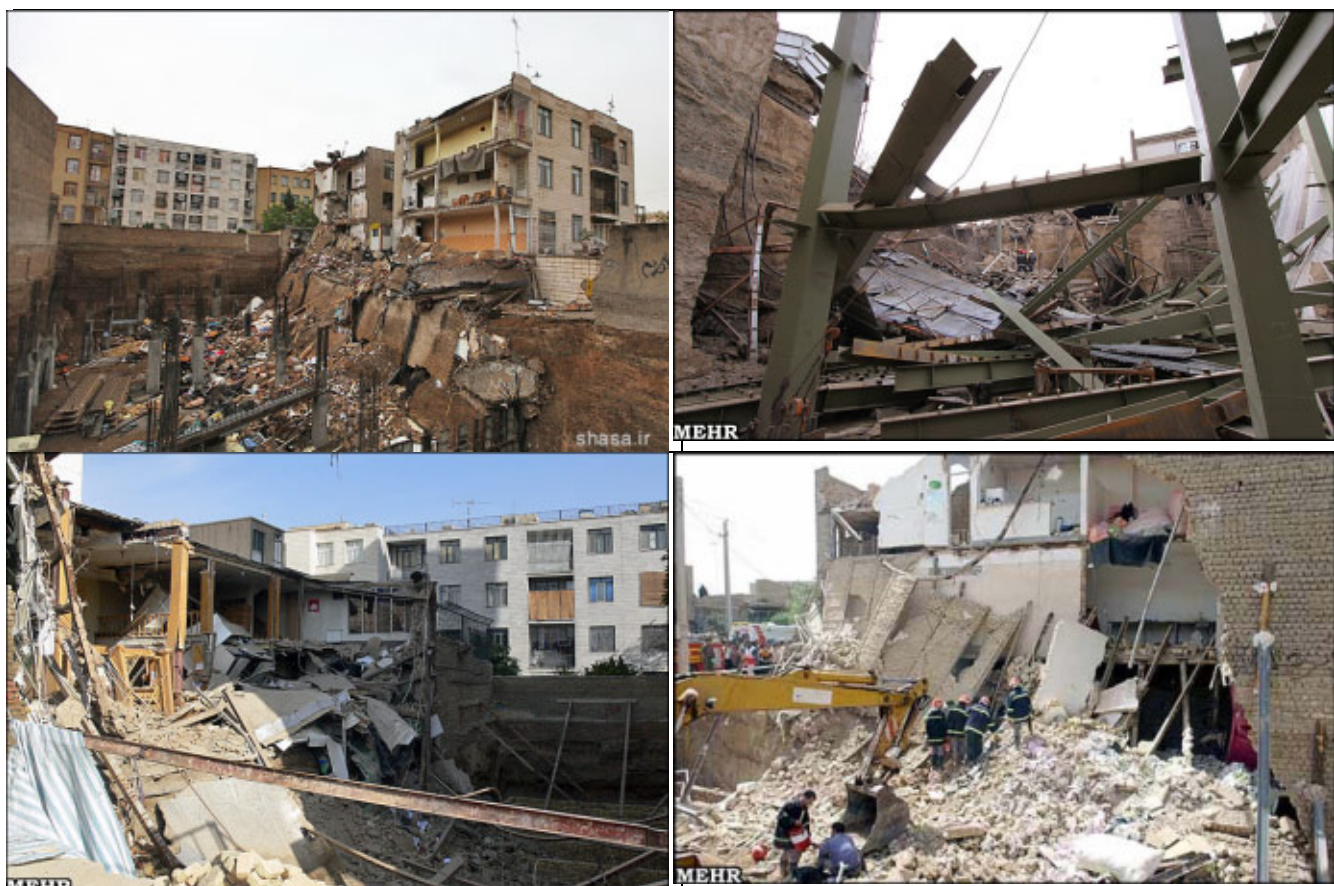
تصویر شماره (۱): تخریب و فروریزش ساختمانهای مجاور گود برداریهای غیر اصولی
