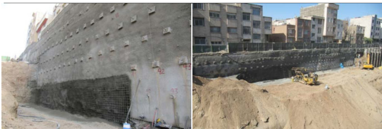
تصویر شماره ۴: اجرای تحکیمات به روش دوخت به پشت یا میخکوبی
