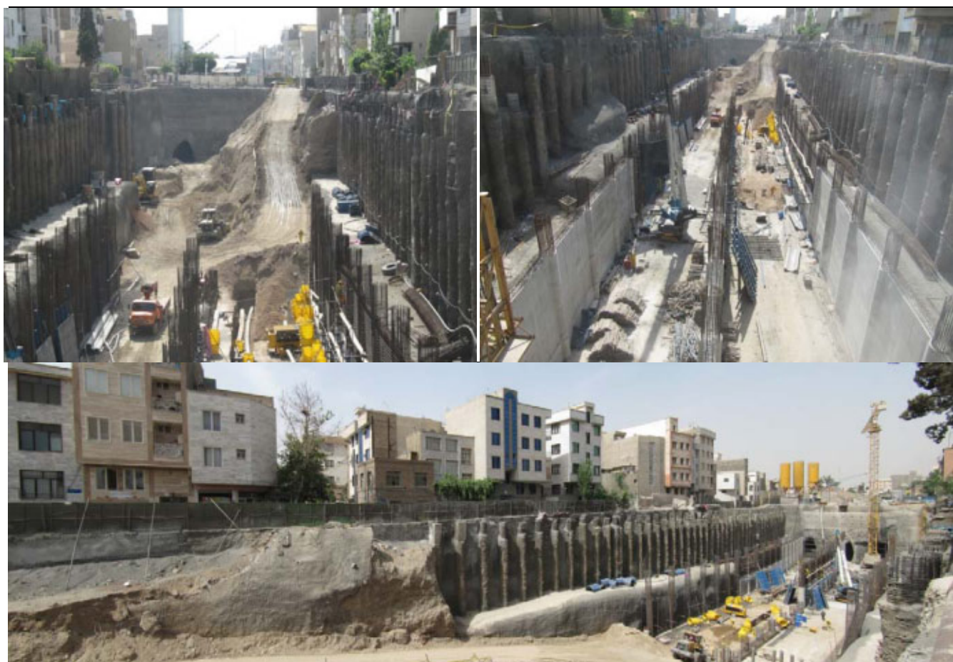
تصویر شماره ۷: اجرای تحکیمات به روش شمع نگهبان
