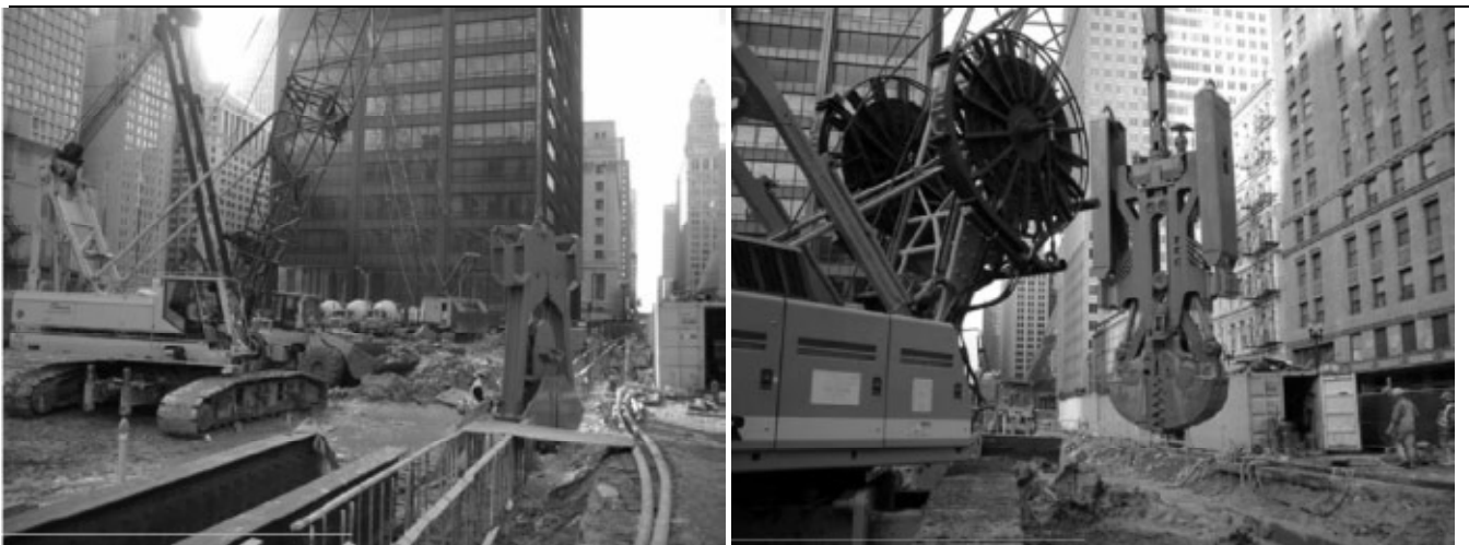
تصویر شماره ۵: اجرای تحکیمات به روش دیوار دیافراگمی
